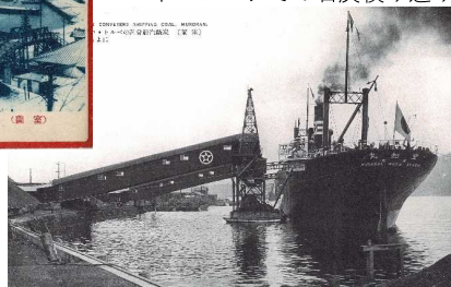
ベルトコンベアでの石炭積み込み
